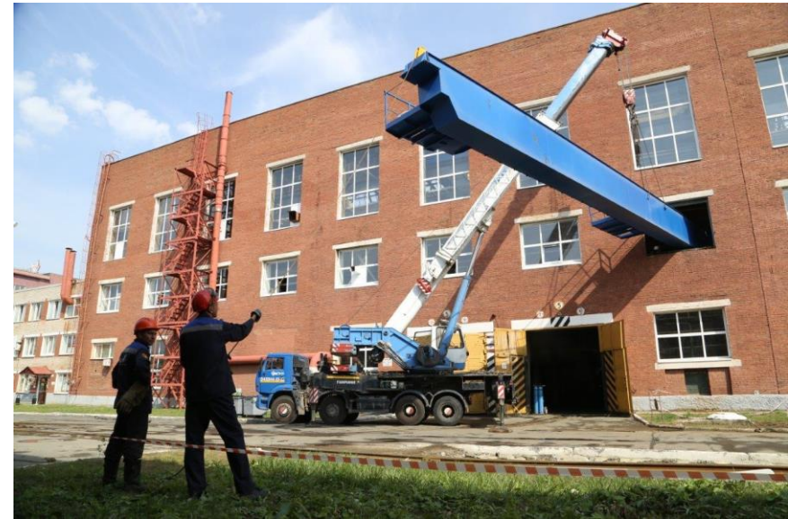
Рисунок 14.1 – Увеличение нагрузок на фундаменты, грунты основания при реконструкции производственного здания (монтаж дополнительного мостового крана)
