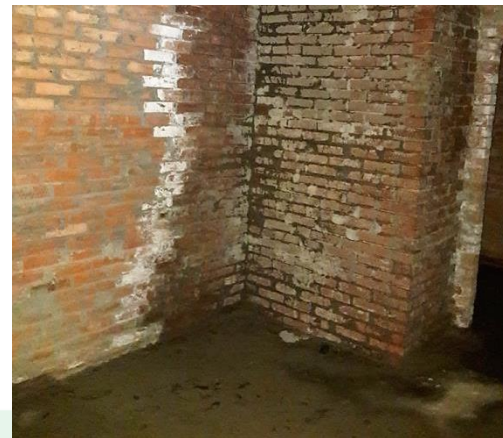
Рисунок 14.2 – Разрушение кирпичной кладки фундаментов здания в результате воздействия агрессивных подземных вод
