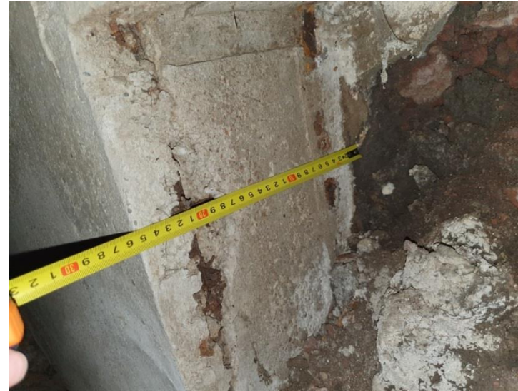
Рисунок 14.4 – Разрушение рабочей арматуры стеновой части железобетонного фундамента в результате ее коррозии
