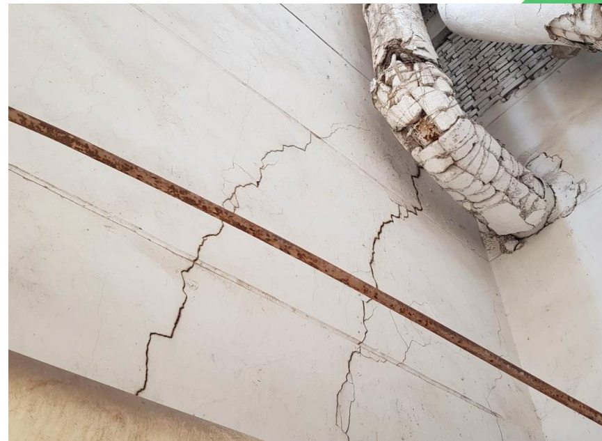
Рисунок 14.7 – Трещины в кирпичной стене гражданского здания вследствие нарушения прочности грунта в уровне подошвы фундаментов
