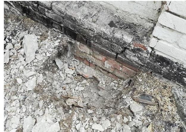
Рисунок 14.2 – Разрушение кирпичной кладки фундаментов здания в результате воздействия агрессивных подземных вод
