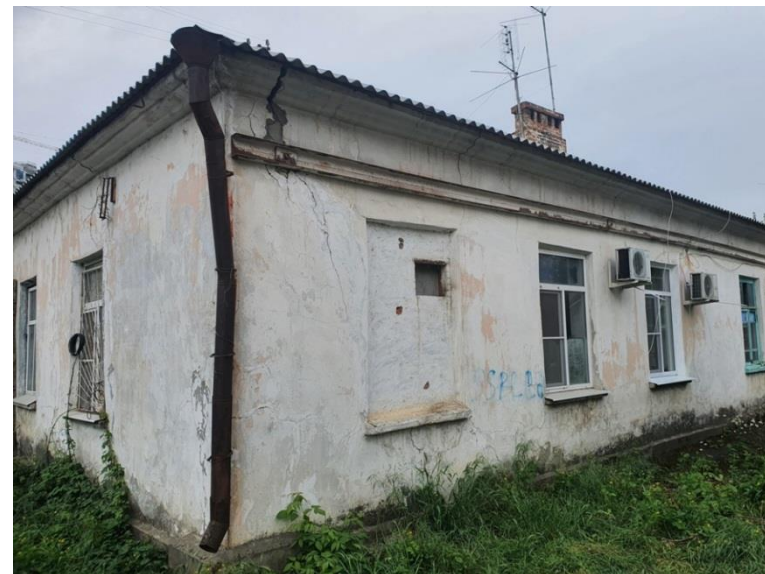
Рисунок 14.5 – Развитие трещин в несущих стенах жилого здания вследствие появления неравномерных осадок фундаментов
