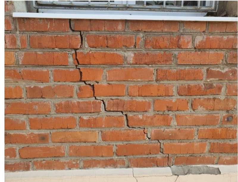
Рисунок 14.6 – Развитие трещин в несущих стенах жилого здания вследствие недоучета особенностей строительства в районе распространения просадочных грунтов
